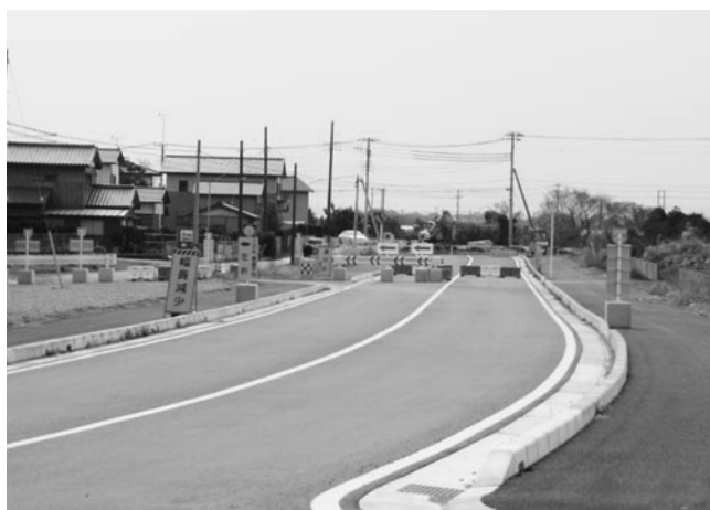
整備が進む飯岡海上連絡道三川蛇園線
