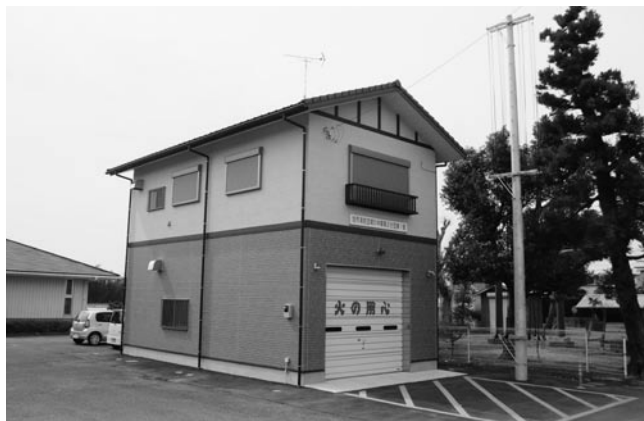
地域の防災拠点となる消防庫
