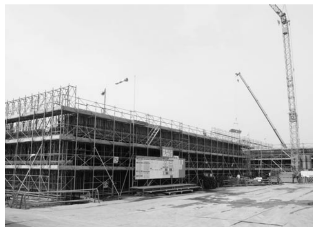
建設が進む(新)飯岡中
