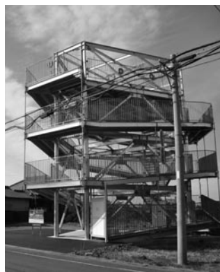
避難タワーの外観(富浦)
